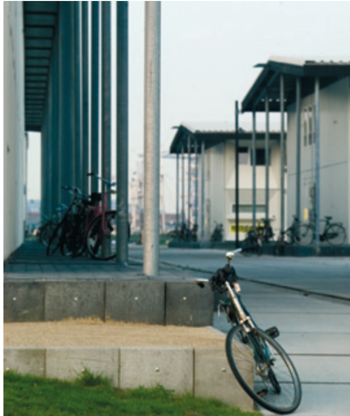
Tijdelijke containerwoningen in de Houthavens.
