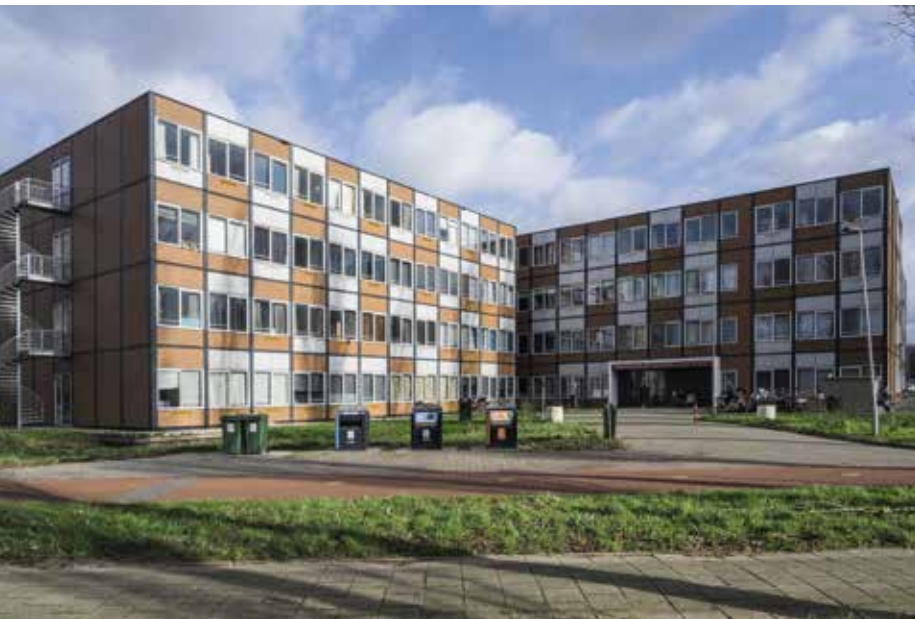
Elan Wonen bouwde 160 tijdelijke woningen voor jongeren en statushouders aan het Delftplein in Haarlem.
