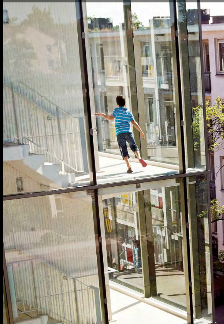
Juni 2010. Bij de renovatie van 'De grote Verfdoos' in Geuzenveld is deze glazen liftschacht annex trappenhuis aangebracht.
