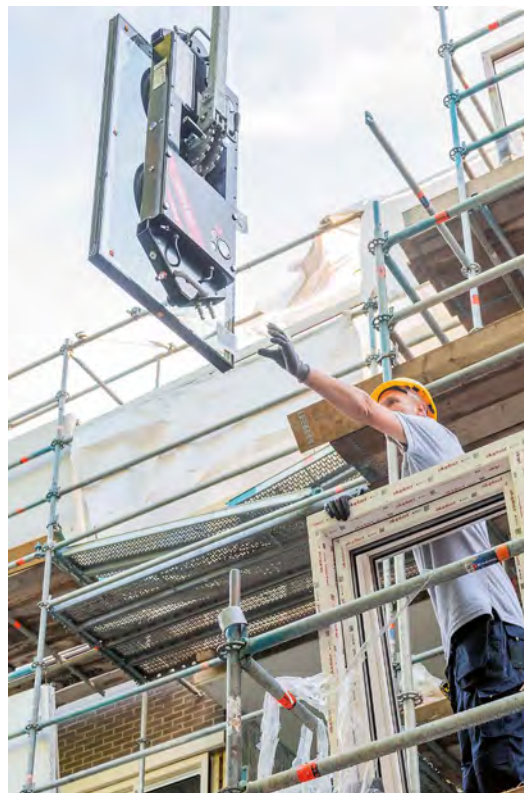
Eerste fase van de verduurzaming van 935 portiekflats in Holendrecht, augustus 2022.
