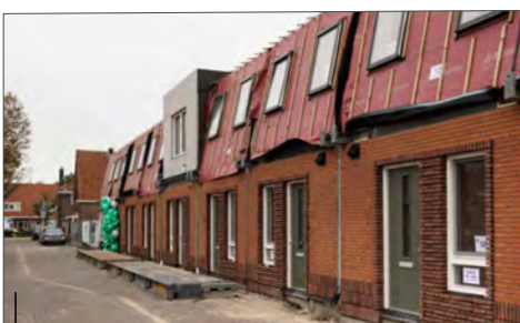
Eerste woningen geplaatst van NH Bouwstroom
