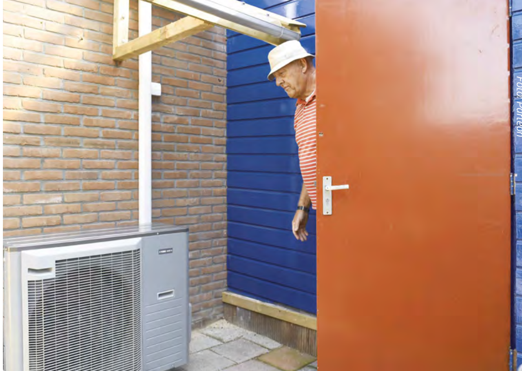
De warmtepomp wordt buiten geplaatst.
